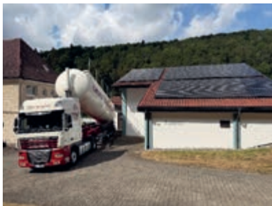
Anlieferung Aktivkohle im Wasserwerk Erpfingen
